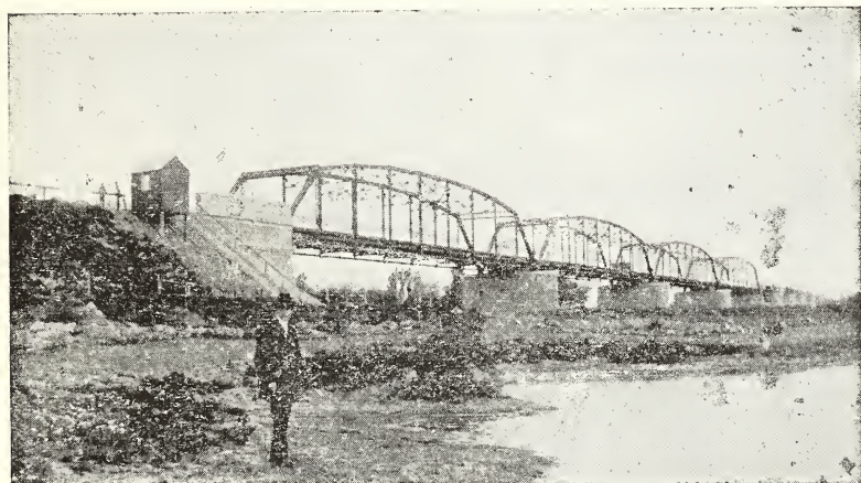
Puente sobre el río San Salvador
